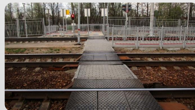
Наземный железнодорожный переход, оснащенный настилами
